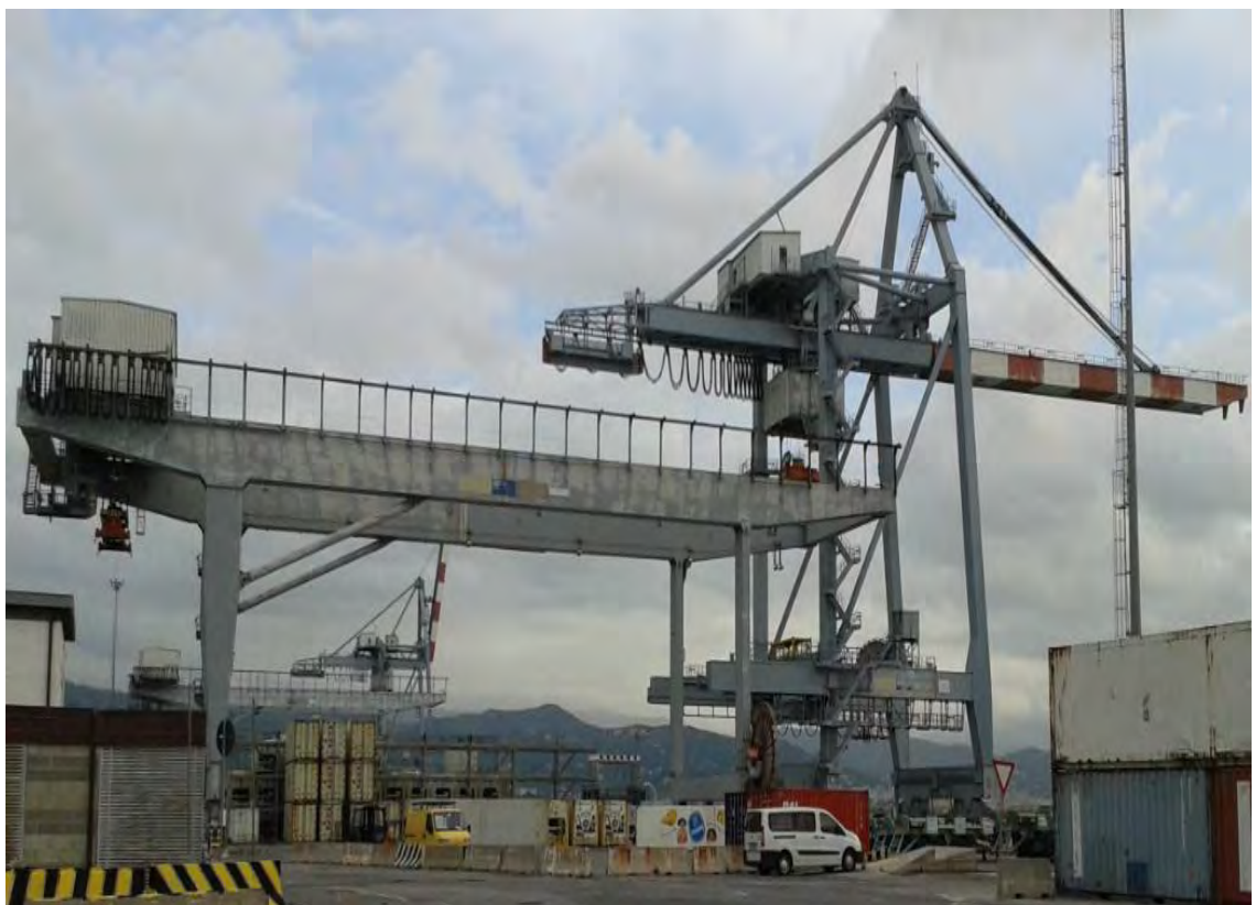
Fig. 2.6 - A sinistra una gru RMG e a destra una gru STS
