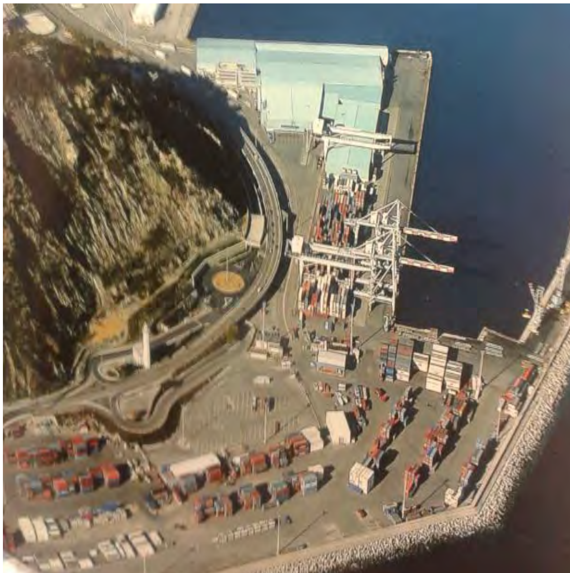
Fig. 2.4 - Vista dall'alto delle strutture del Reefer Terminal
